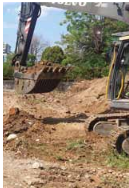
L'inizio dei lavori per la riqualificazione della Terrazza Bergamina
