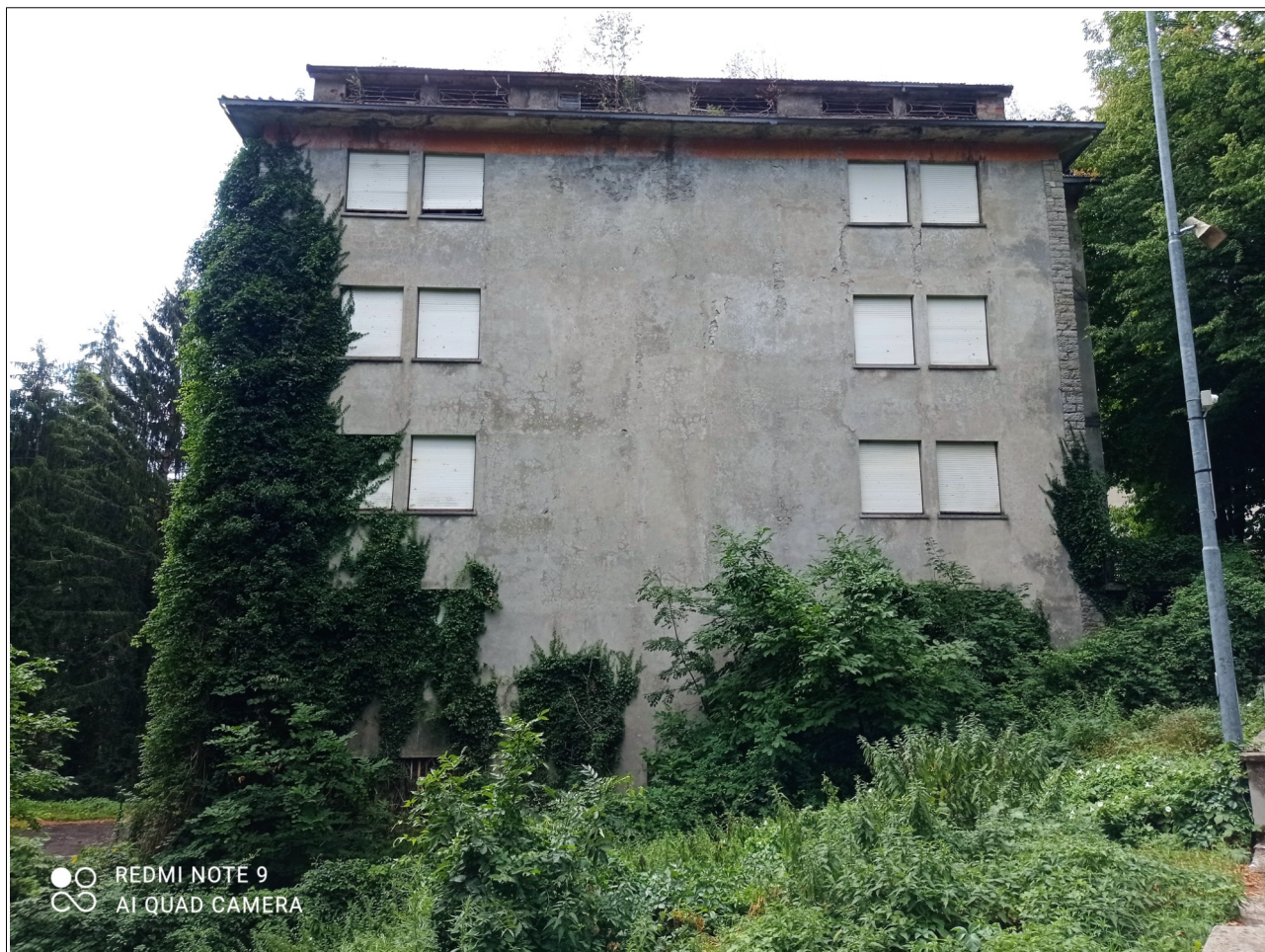
FOTO PROSPETTO NORD
